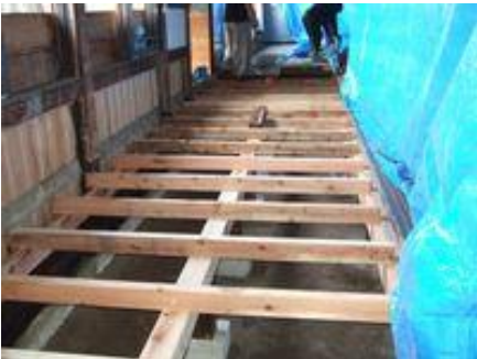
↑ シロアリ被害でブカブカだった本堂の廊下の床を直し、隙間だらけの窓もサッシにしました。
